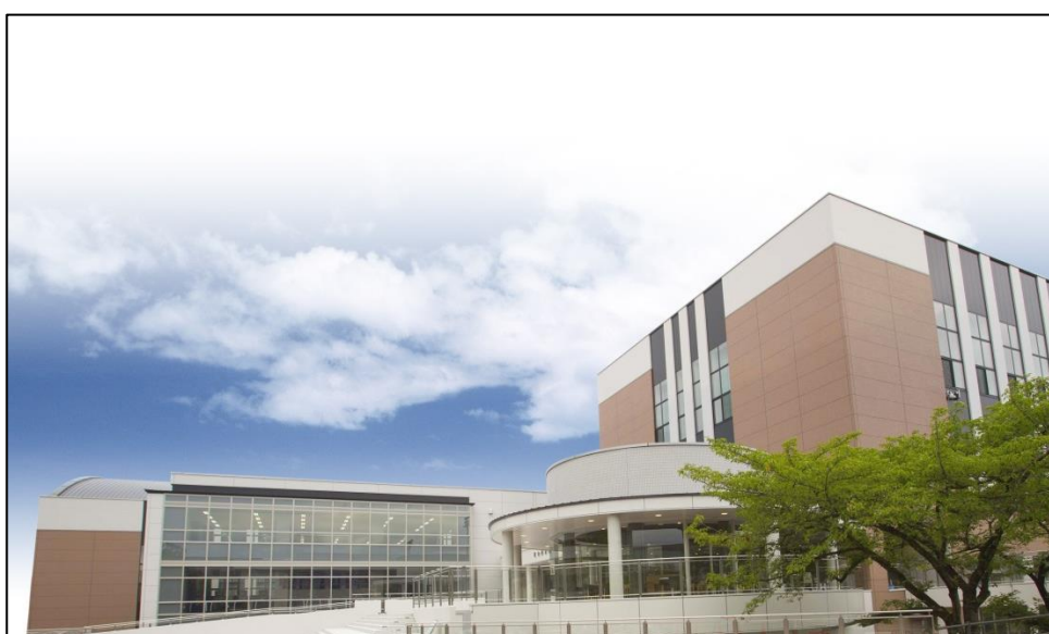
完成した「総合体育館」
