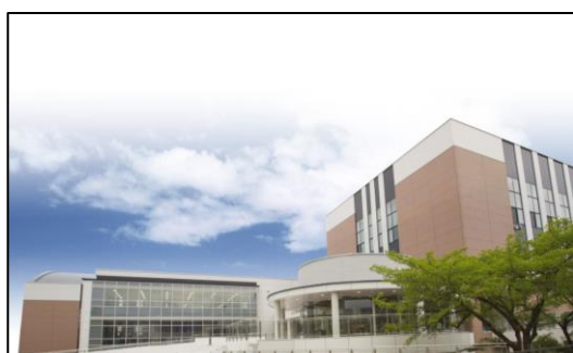
完成した「総合体育館」
