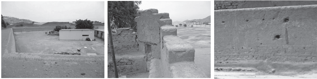
写真2 左：五角形の稜堡上部 中：五角形の稜堡先端部 右：厚さ5mのアドベの壁
