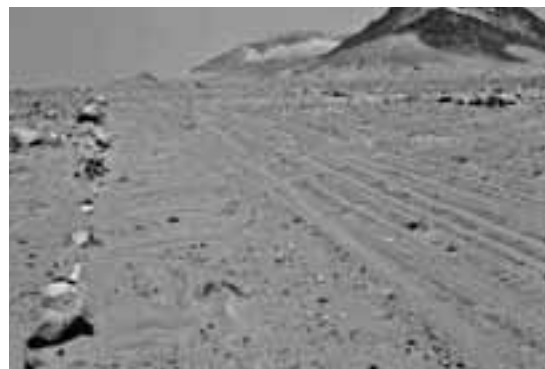
図6 図2のD点付近(1985/8/16筆者撮影) (10~20cm大の石1列の路側帯、内法15m40cmN10°Wのインカ道)
